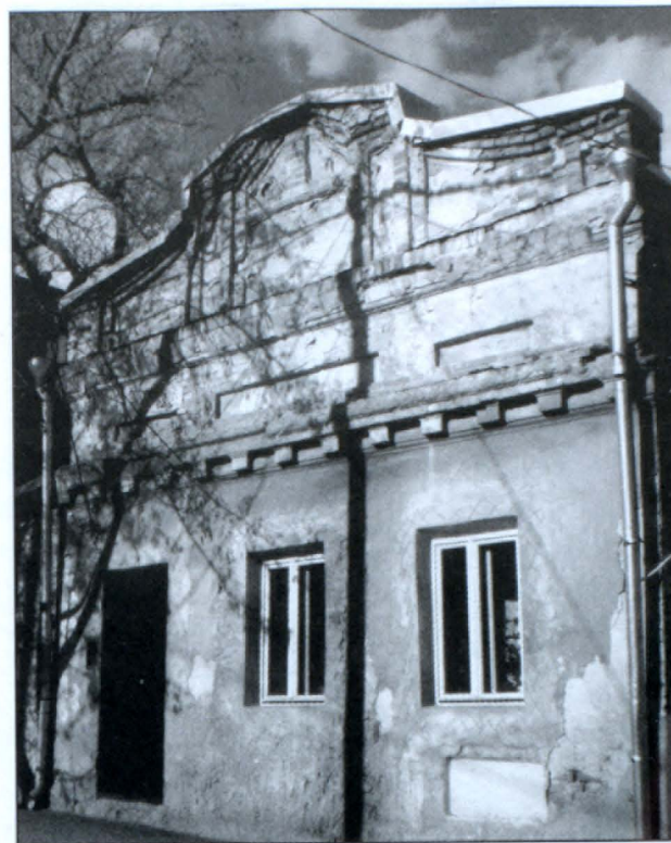
Здание часовни, возведенной на первоначальном фундаменте соборной церкви Нахичевани.
